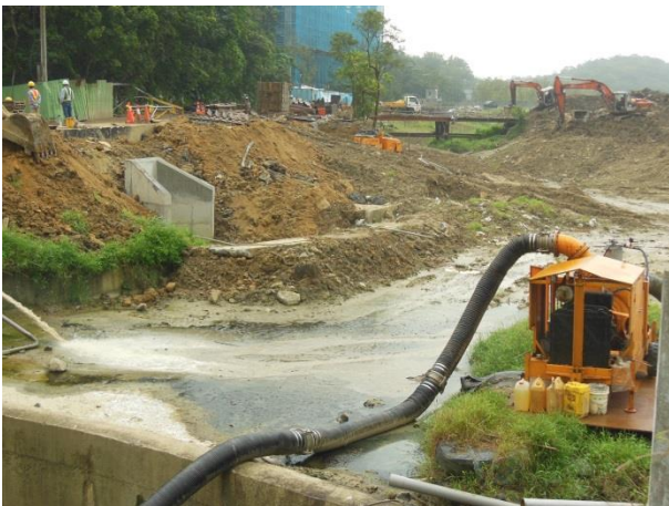
(1) 原水域樣站受抽水施工影響乾枯
