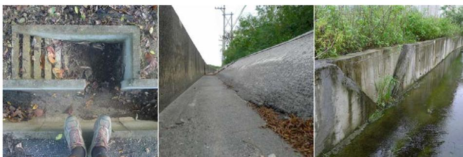
圖 4.2.1-11 排水設施動物逃生坡道設計示意
