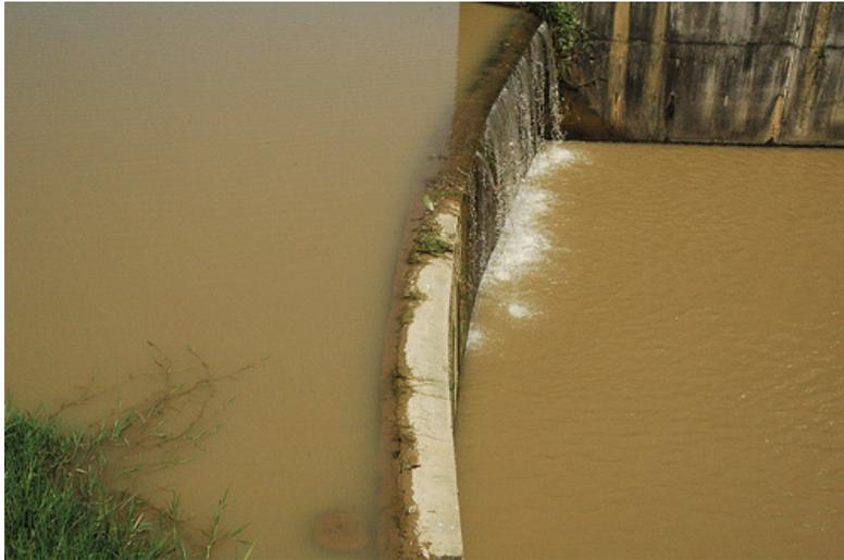
圖 4.2.2-2 滯洪池下游溢流斷面可能造成阻隔效應
