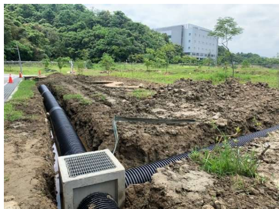
設置碎石溝（內埋設透水管）加強排水
