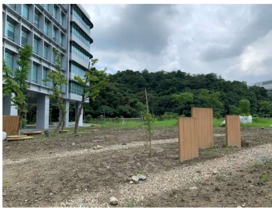
原低窪易積水之地勢以砂質壤土勢墊高，並整出洩水坡度以利排水
