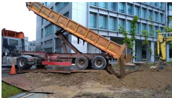
原低窪易積水之地勢以砂質壤土勢墊高，並整出洩水坡度以利排水
