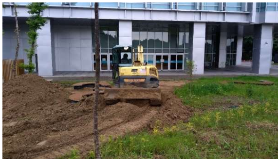
原低窪易積水之地勢以砂質壤土勢墊高，並整出洩水坡度以利排水
