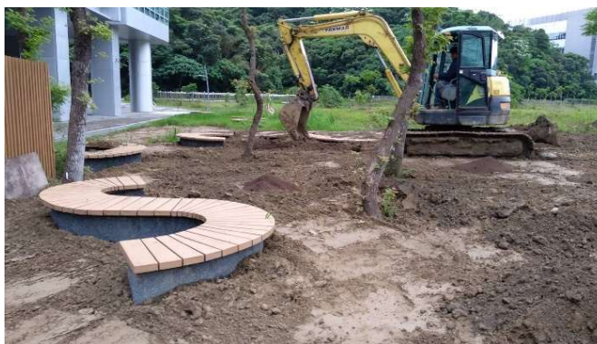
回填區之砂質壤土拌有機肥，以利植栽生長
