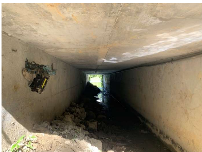
動物通道內部單側填高，保持乾燥動線供動物利用
