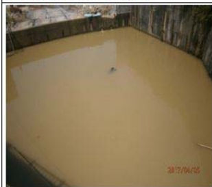
3. 106/4/5 發現發現溢流堰下方泥沙淤積且廢水沉澱空間與時間不足。
