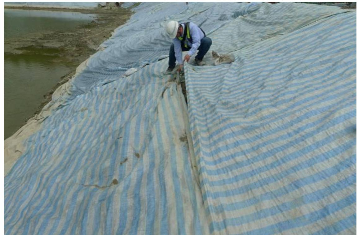
生態池邊坡加速植生護坡作業，尚未施作植生區域以帆布覆蓋，避免雨水沖刷以維持良好水土保持功能。
