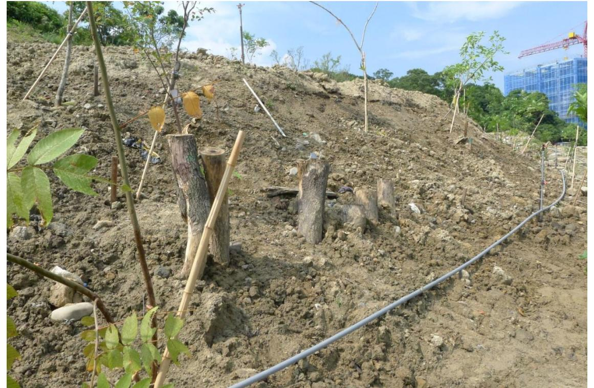
邊坡易坍塌區利用木樁進行護坡加固作業
