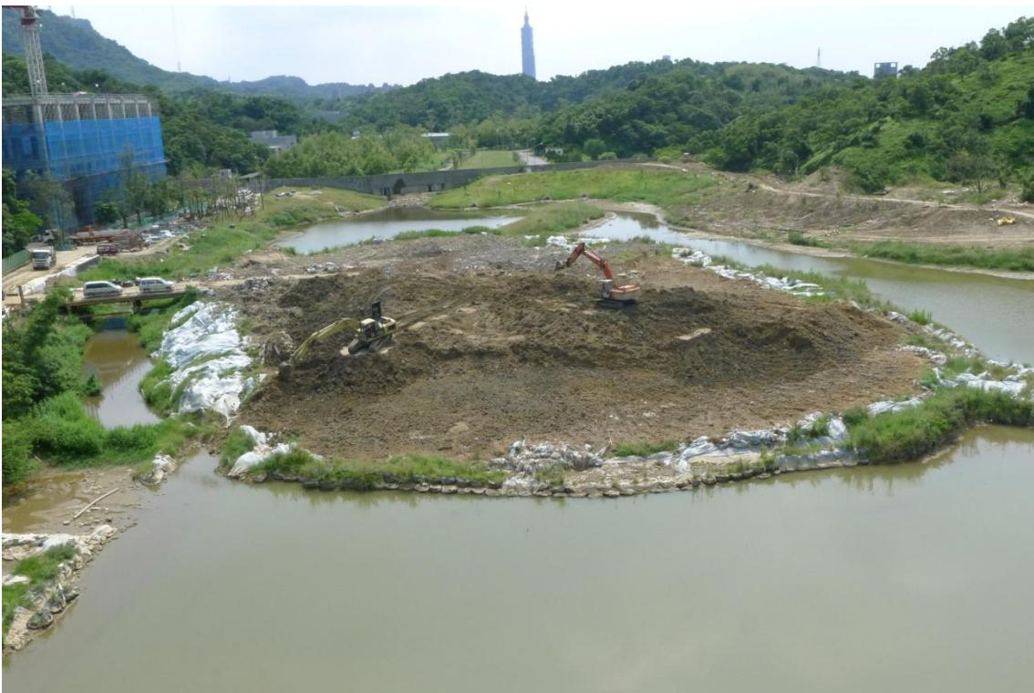
土方暫置區盤土作業時暫時撤除帆布，以利機具作業
