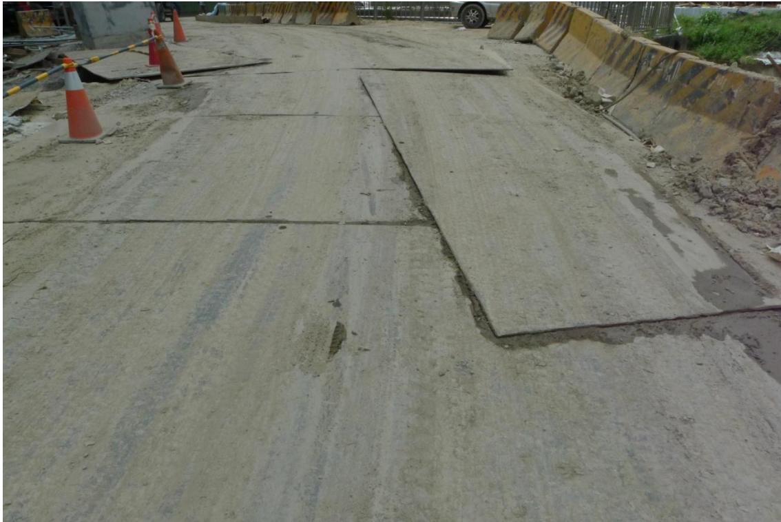
施工動線鋪設鋼板，減少路面泥濘及土壤裸露問題
