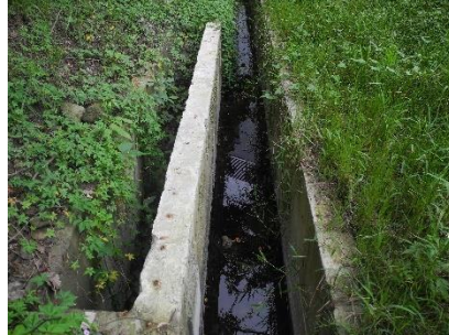
(11)水保溝渠動物逃生坡道本季陸續施作完-2018/10/6
