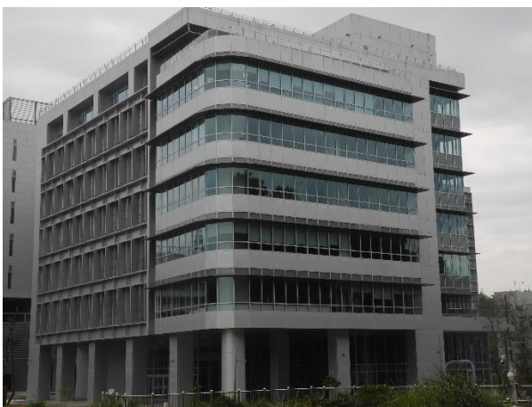
研究專區大樓玻璃帷幕已有鳥擊傷亡事件發生，急需進行改善
