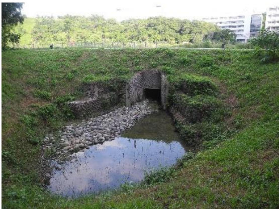
南側動物通道簡易拋石複式通道本季增建完成，但監測結果顯示仍僅有鷺科等鳥類利用，未見哺乳類利用，建議持續改善。
