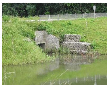
(5)南側道路動物通道坡度改善作業已完成。但因通道複式結構遲未施作，使得出口淹沒在水中，無法提供做為哺乳類的動物通道 -2018/10/6
