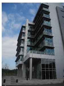
(7)部分大樓牆面玻璃仍有鳥擊危險，目前已建立鳥擊通報系統，積極監測並持續改善中-2018/10/6
