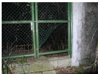
(17)北側生態保留區山徑管制門遭毀損，已通報修復-2018/11/20
