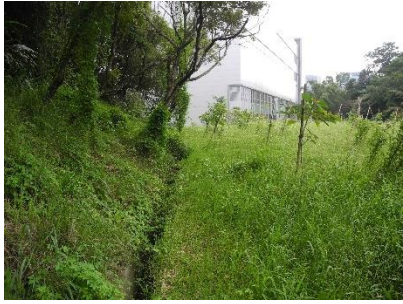
(10)G 棟後方堆土區植栽完成，但水保溝渠缺乏跨越通道，僅有逃生坡道設計，建議應予改善-2018/10/6
