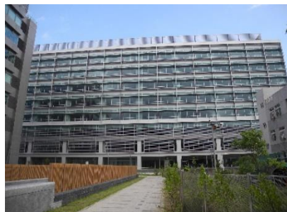
(8)2~3樓為鳥擊玻璃熱門高度，本案部分大樓藉由加裝外牆柵欄及鑲嵌低反射玻璃的方式，來降低鳥擊頻度 -2018/10/6
