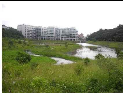
(1)生態滯洪池西北側草澤、浮島、邊坡草地、原生樹苗復育區濕地地景逐漸成形，後續維護應慎選具備生態演替知識廠商來維護，避免破壞復育不易的植栽棲地-2018/10/6
