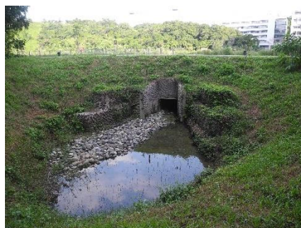
(4)南側動物通道本季末以拋石營造複式斷面，但因石頭縫隙大，通道面積小，水稍大就淹沒在水中，架設之監測相機僅記錄鷺科鳥類利用-2018/10/6
