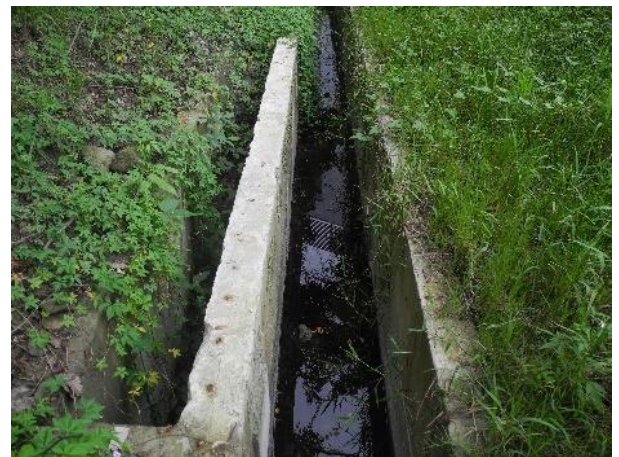
國家實驗動物中心後方 F51 排水溝渠陡深，動物逃生坡道已完工，建議增加動物跨越通道。
