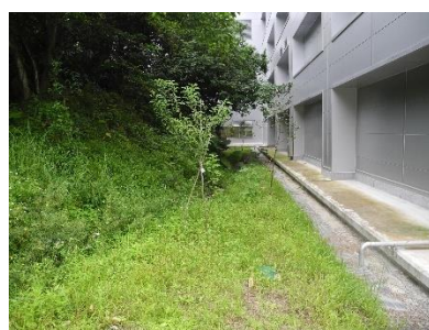
(9)本案位於小型凹谷內的大樓，周邊溝渠採用草溝或砌石溝的方式構築，具有涵養水源，友善生物棲息等效用-2018/10/6
