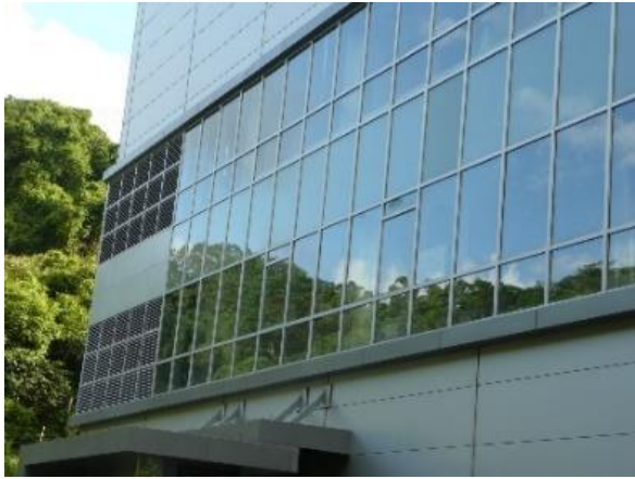
牆面玻璃反射周邊森林棲地，形成假性棲地，是造成鳥擊傷亡的主要原因，可於窗戶外側利用符合 5 公分*10 公分原則的點狀貼膜來改善-2018/8/23
