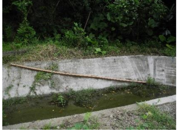
北側水保溝渠本季構築 3 處動物逃生坡道，方便誤入的動物得以順利逃脫-2018/8/24
