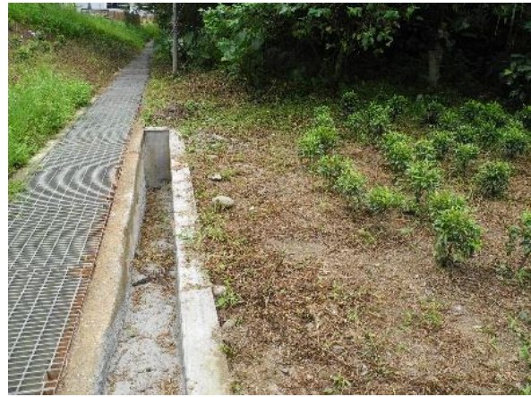
北側水保溝渠本季完成動物逃生坡道設置 -2018/8/24
