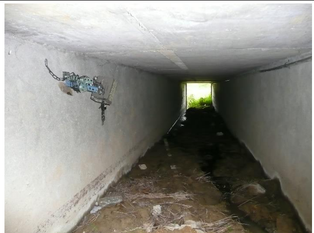
南側動物通道監測相機架設
