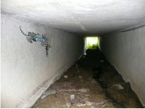
南側動物通道複式結構未施作，無法提供哺乳類通行。本季新架設相機監測通道使用狀態-2018/8/23
