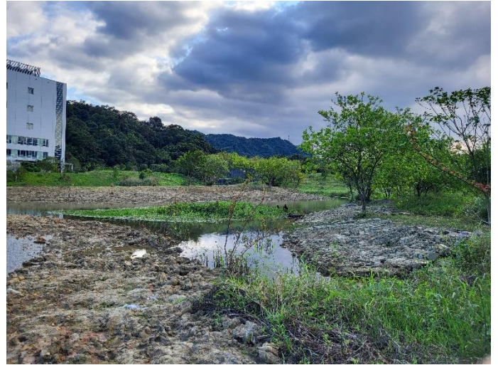
(2) 滯洪池進行清淤除草整地作業
