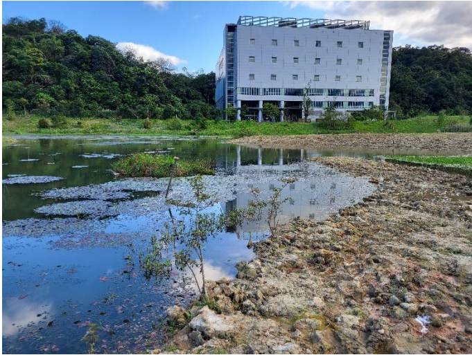
(1) 滯洪池進行清淤除草整地作業
